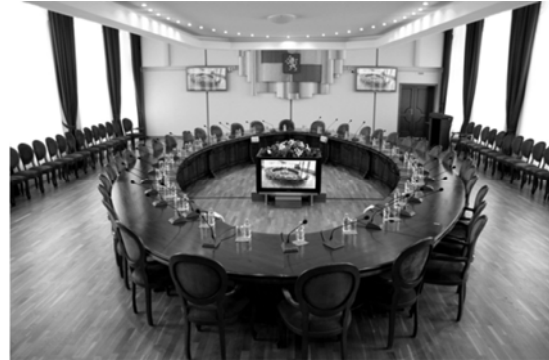
Рис. 4. Расположение микрофонных блоков, источники сигнала расположены на колоннах за шторами
